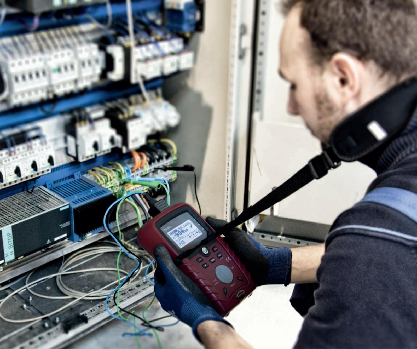
Adaptadores, comprobador de instalaciones, de instrumentos y de campo magnético rotativo
